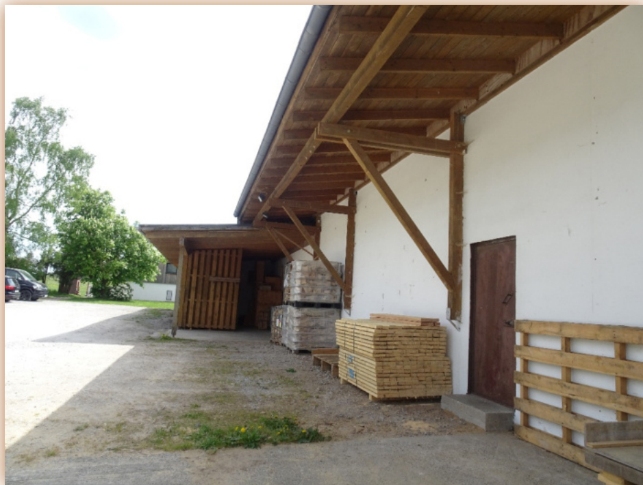
Abbildung 17: Vorplatz der Schreinerei, der überbaut werden soll
