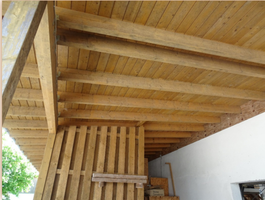
Abbildung 18: Dachkonstruktion ohne für Fledermäuse geeignete Spalten
